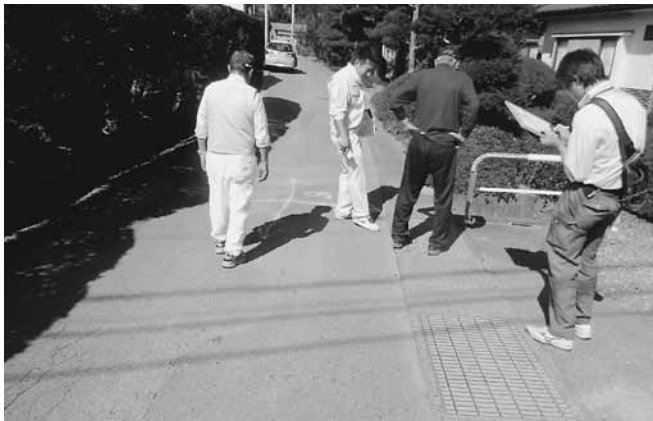
(村内道路状況の点検)
