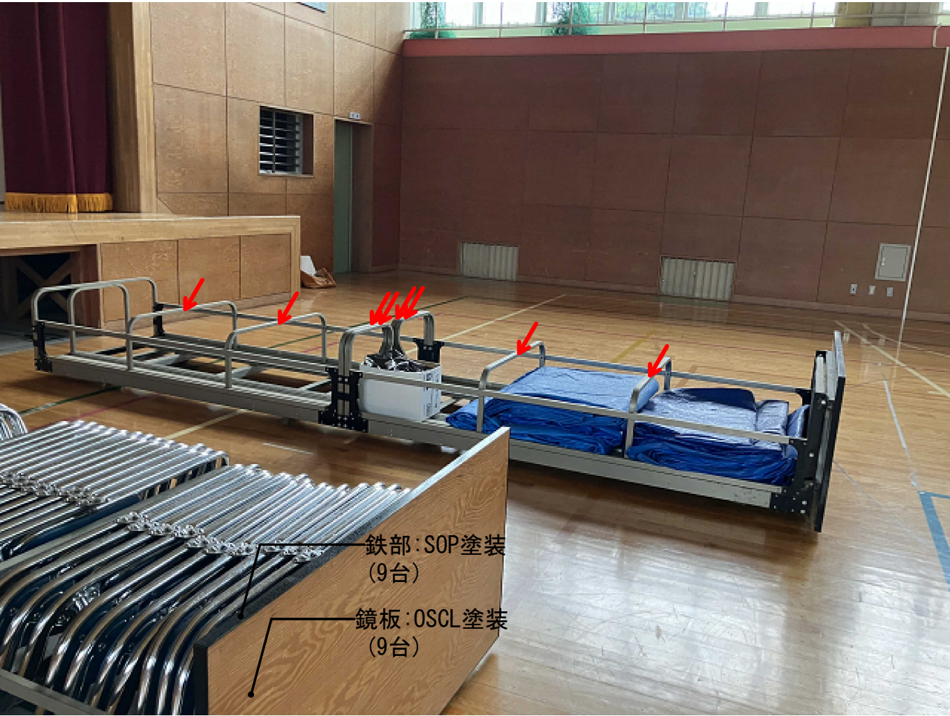
万能型へ改修 矢印部を撤去・・・2ヶ所
