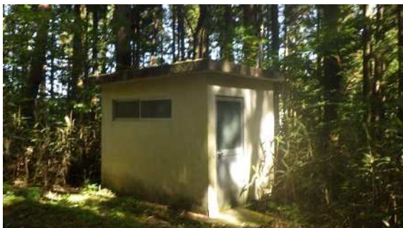
(送水ポンプ室)
