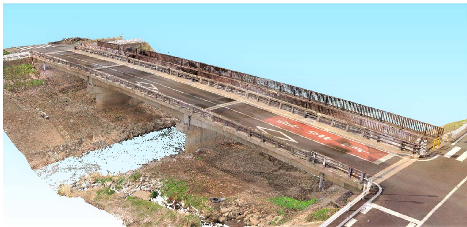
松ノ木橋（2021 年修繕）
