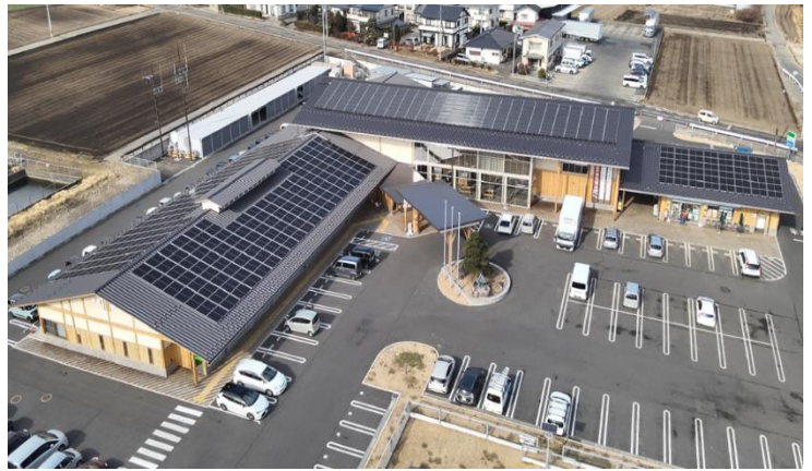
(村役場の発電設備の設置状況)
