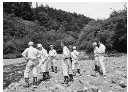
第三堰堤現場
