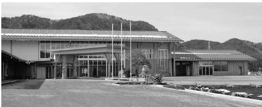
(完成間近の新庁舎)
