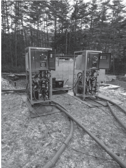
仮設ろ過装置設置状況
