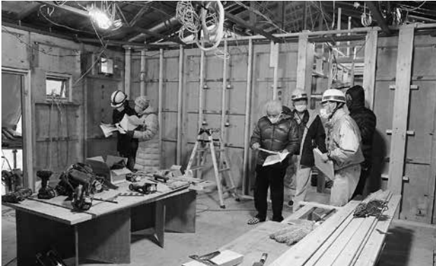
改修中の村営住宅
