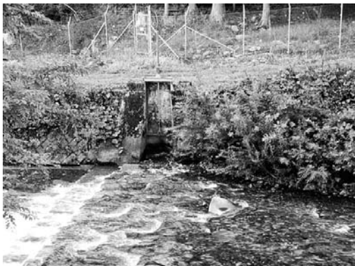
針尾水路頭首口
