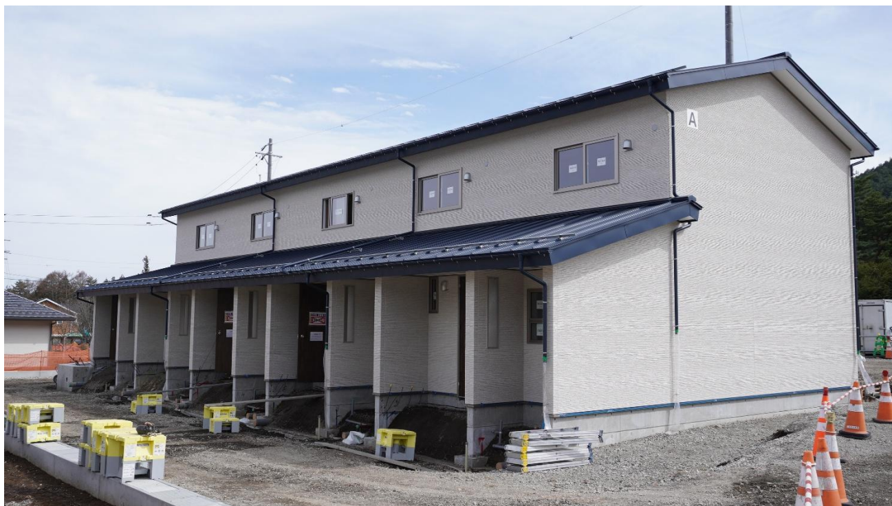
建設工事状況4月上旬
