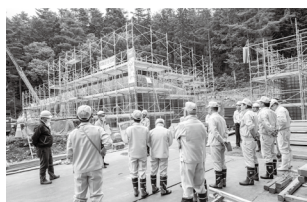
大尾沢浄水施設建設
