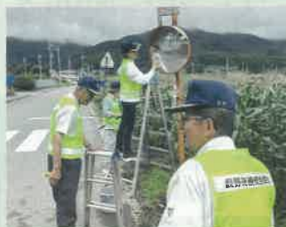
町内の小学校・保育園・幼稚園の近くに設置されたカーブミラーの点検・清掃作業を実施した。(辰野)
